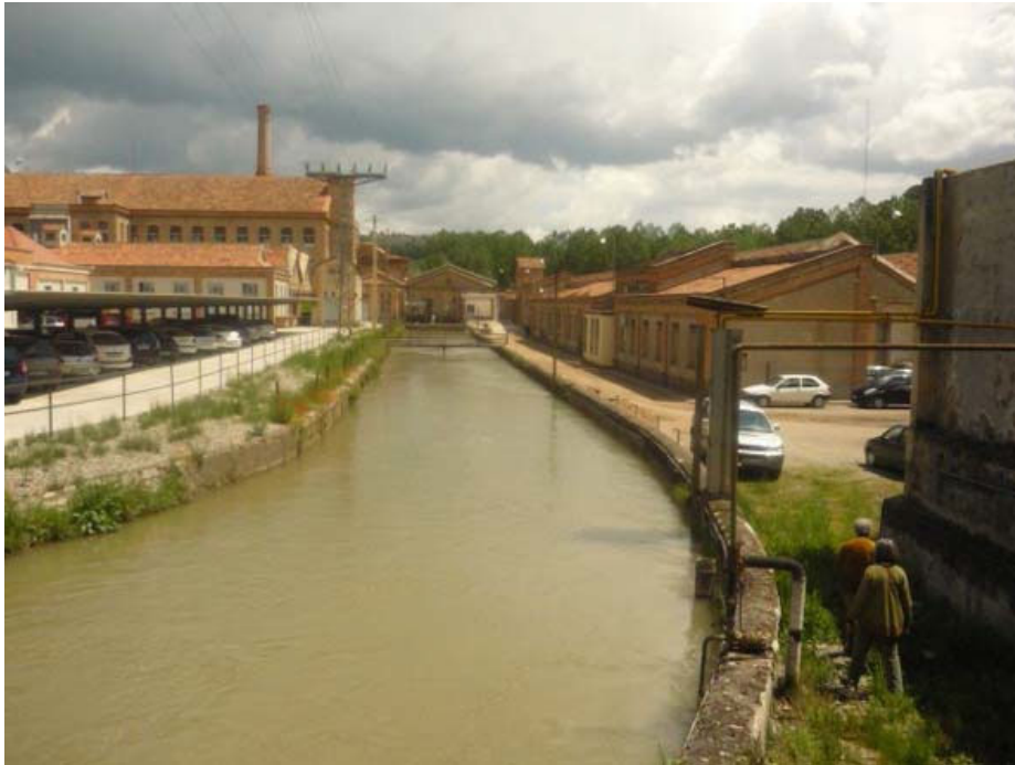
El canal d'entrada dirigit-se cap al recinte fabril, amb el salt d'aigua al fons (G-R)
